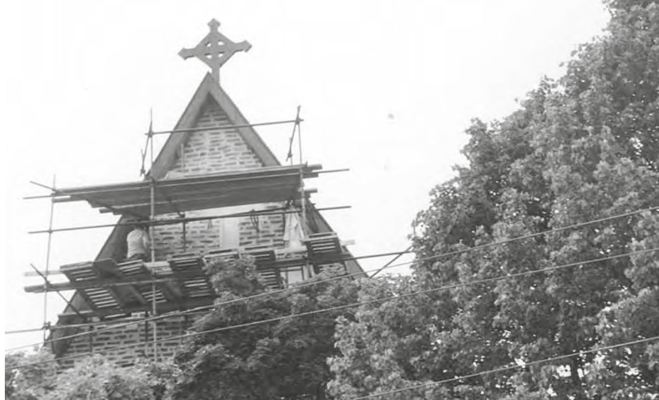
Muurien korjauksia varten pystytettiin telineet itäpäätyyn keväällä 1983, TKsrkA.
