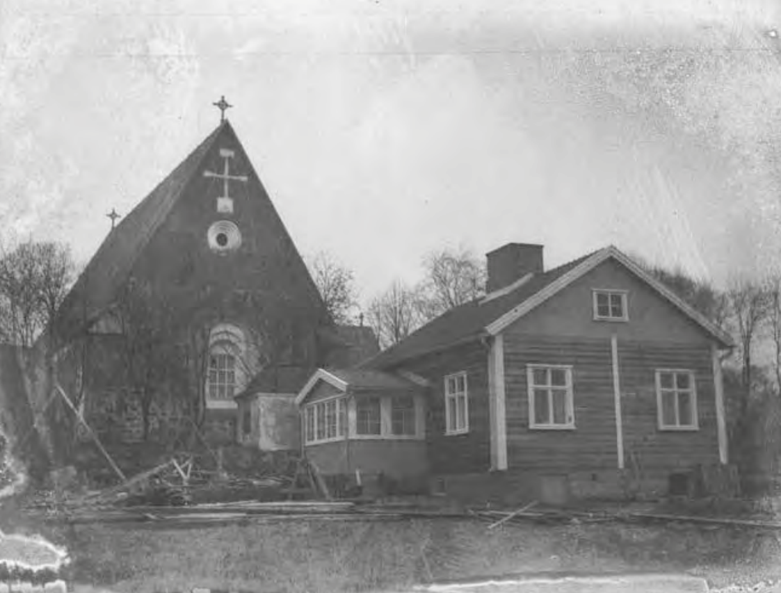
Kirkon itäpuolelle valmistui hirsirakenteinen vahtimestarin asuinrakennus. Kuva vuodelta 1939, TMK.
