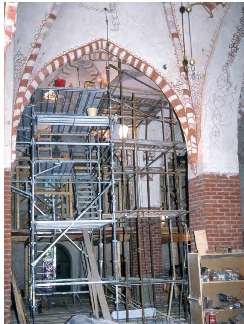
Holvien korjauksia ja kalkkimaalausten konservointia varten tarvittiin rakennustelineet. TKsrkA.
