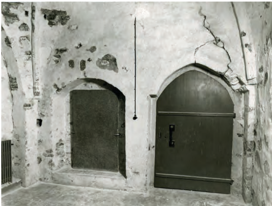
Vuosikymmenien saatossa oli asehuoneen holveihin syntynyt halkeamia. P. O. Welin 1982, TKsrkA.
