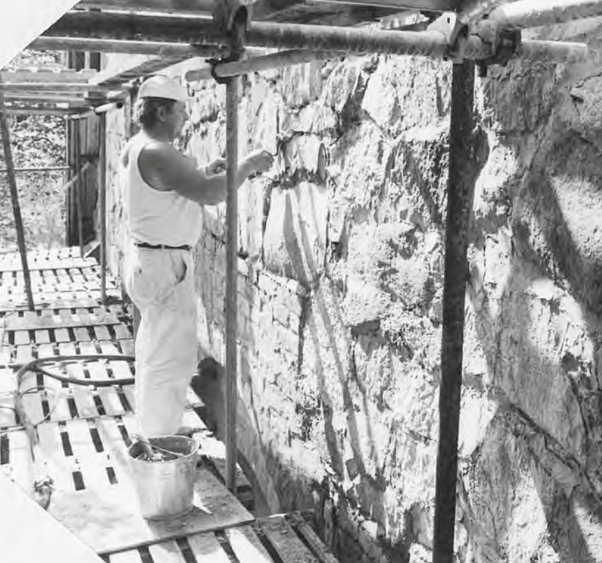
Itäpäädyn muurin saumalaasteja uusittiin kesällä 1983. TKsrkA.
