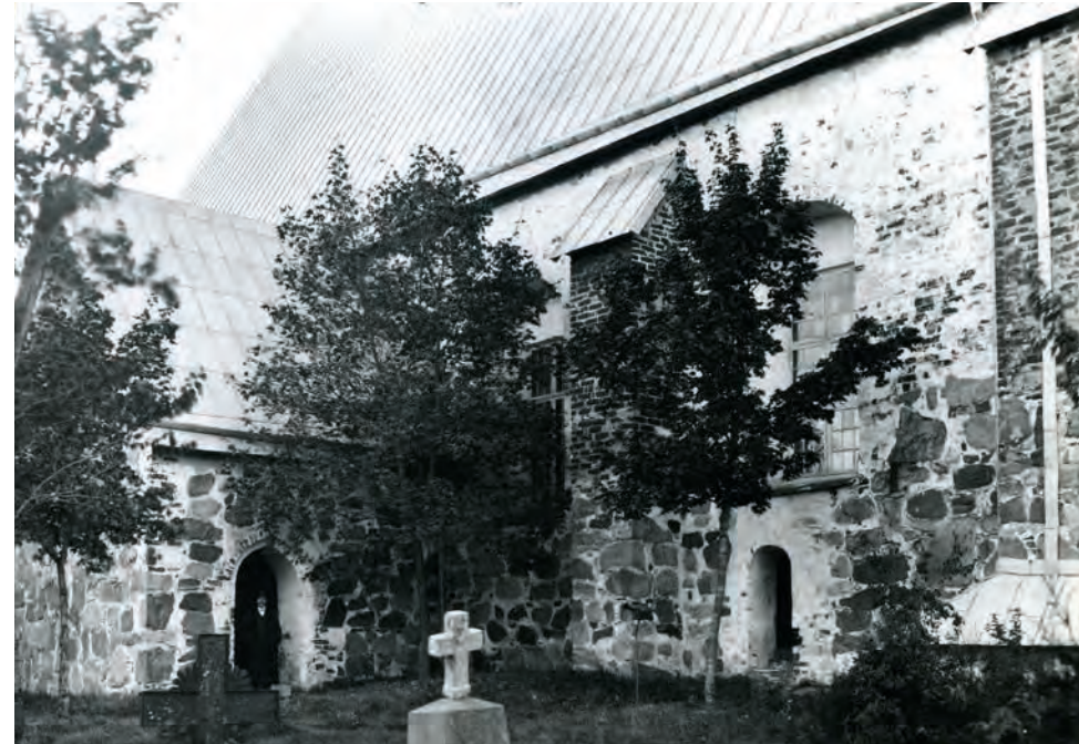
Eteläjulkisivun ikkunat ennen suurentamista. Vesikaton peltikate oli asennettu 1870-luvulla. C. Frankenhaeuser 1900, TKsrkA.
