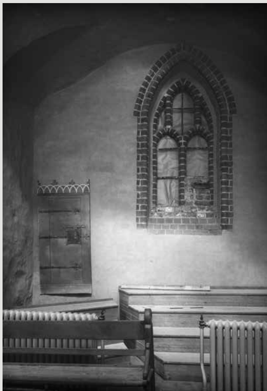
Kappeli vuonna 1928 korjaustöiden aikana. HK.
