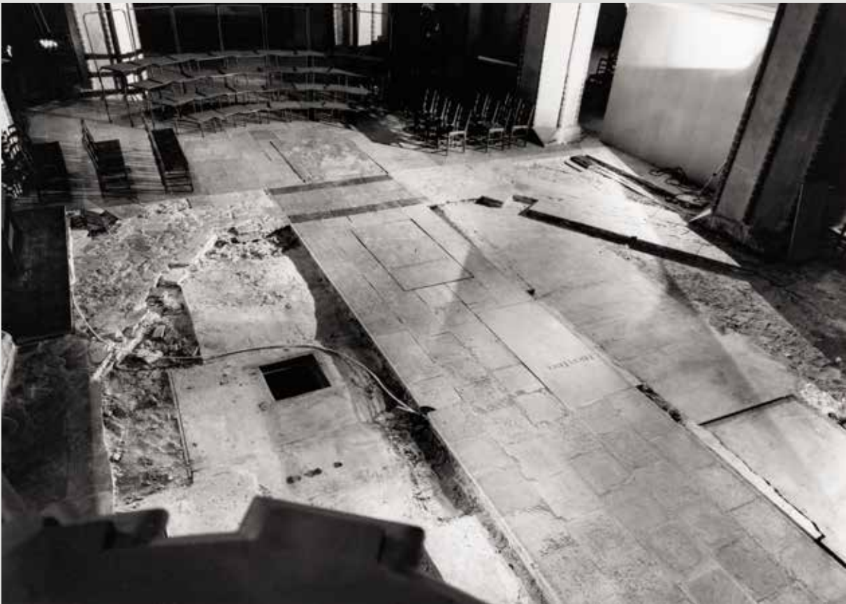
Kirkkosalin lattian muutustyöt penkkien poiston jälkeen. P. O. Welin 1998, RHO.
