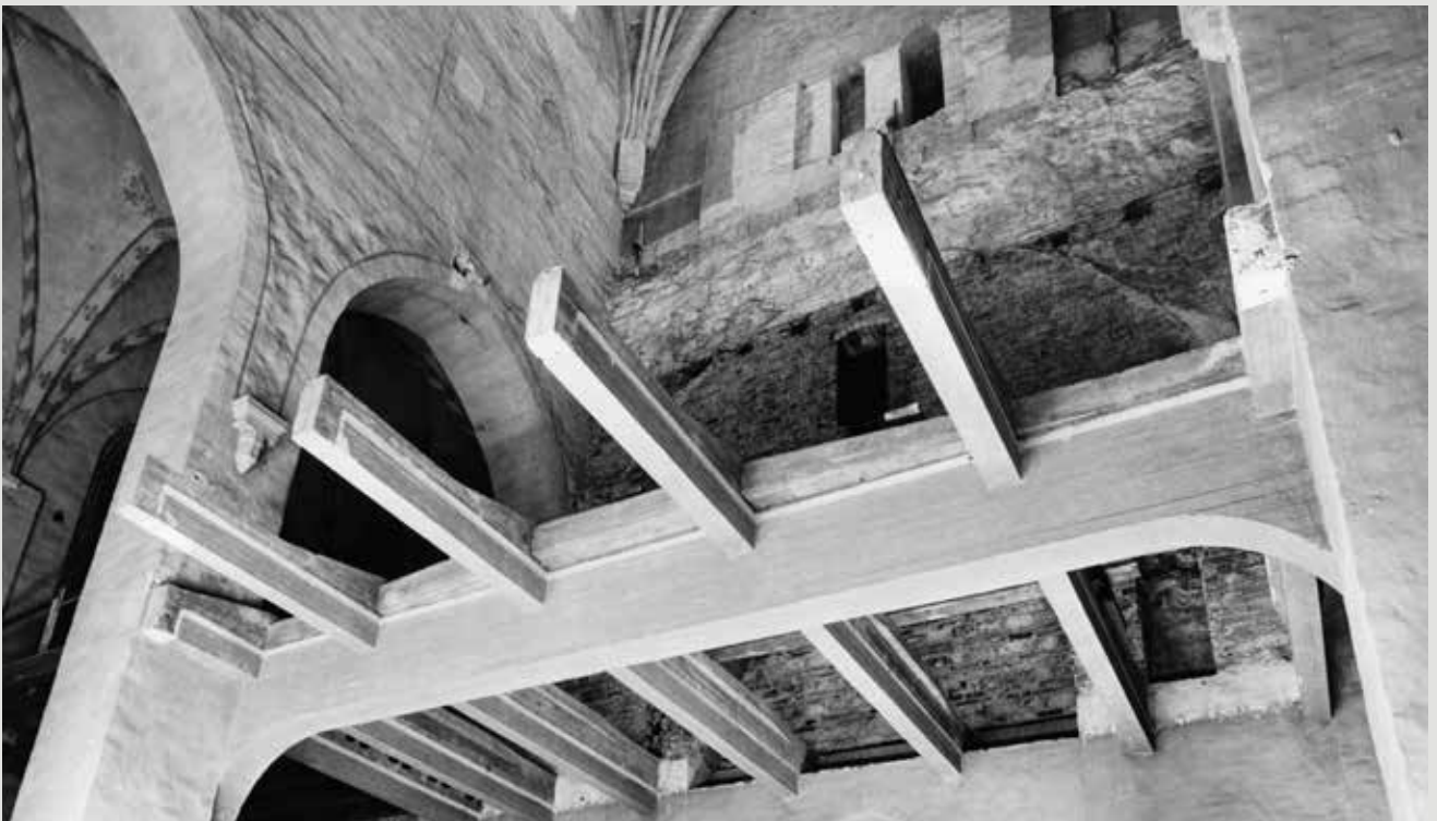
1920-luvulla uusitun urkukarven betonirakenne. P. O. Welin 1977, RHO.
