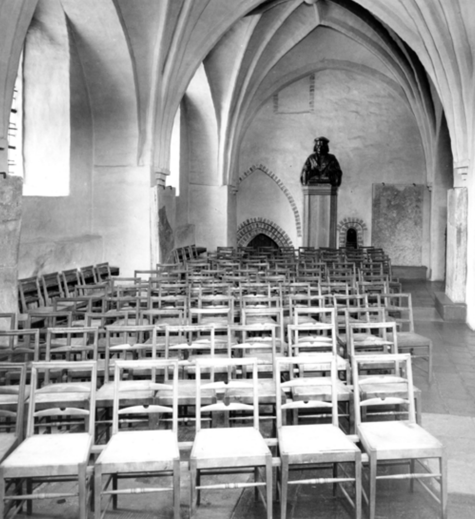
Kappeli ennen peruskorjausta vuonna 1977. P. O. Welin, TKsrkA.
